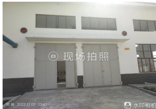
粗格栅及进水泵房
