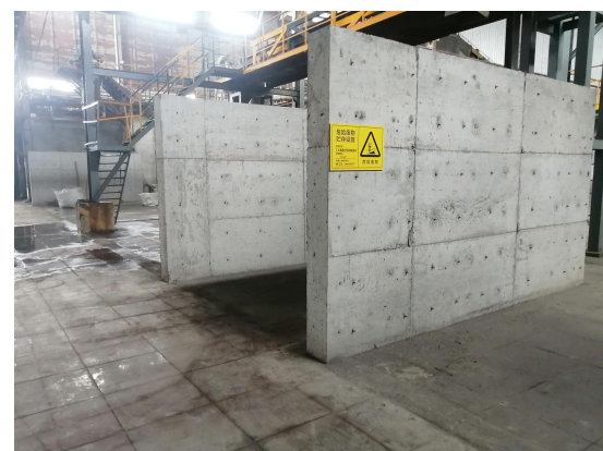
危险废物贮存设施
